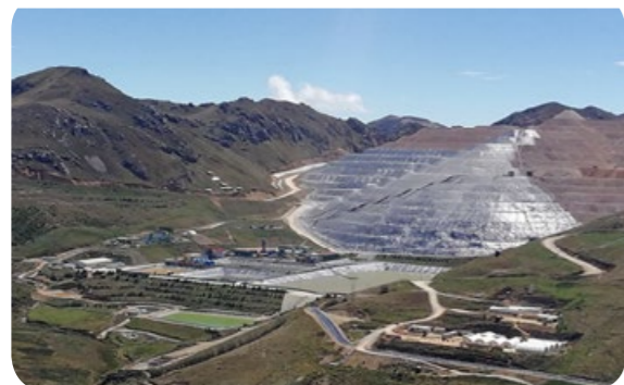
Vista panorámica del PAD de lixiviación cubierto con geomembranas
