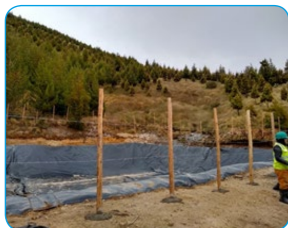
Microreservorio para captar aguas de lluvia
