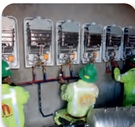
Instalación del sistema de calentamiento de agua.
