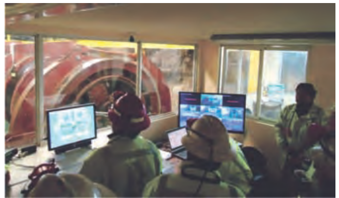
Cabina de control del winche.
