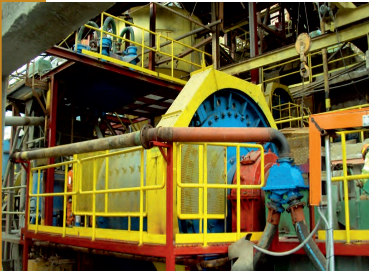
Vista del molino instalado.
