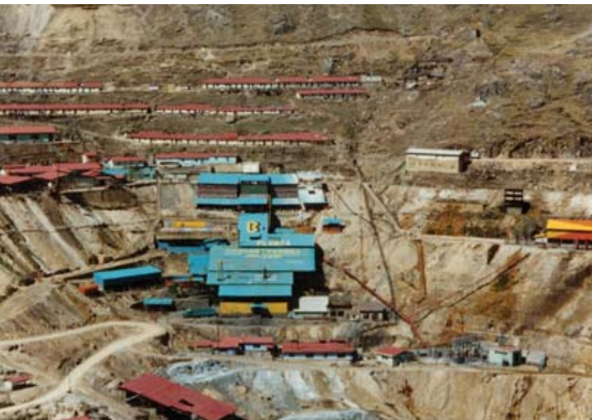
Vista de la Unidad Julcani, Buenaventura, Huancavelica.
