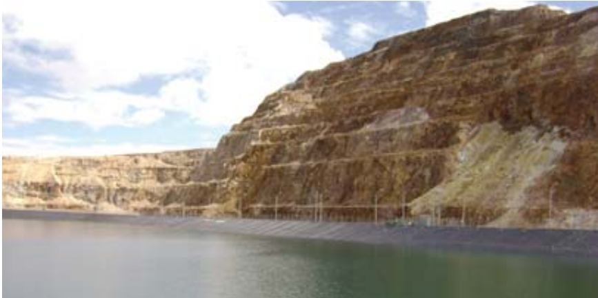
Reservorio San José, Minera Yanacocha, Cajamarca.
