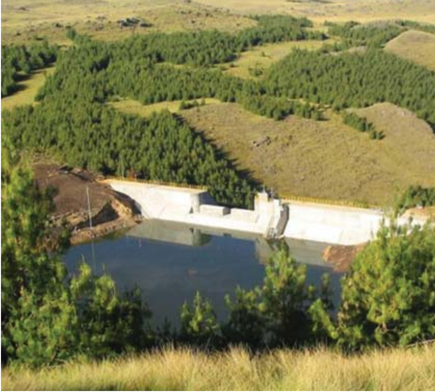
Presa Río Rejo, Minera Yanacocha, Cajamarca, almacena 400 mil m 3 de agua.
