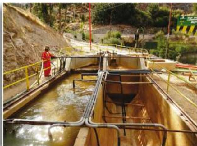
Funcionamiento de líneas de recirculación y purga de lodos.
