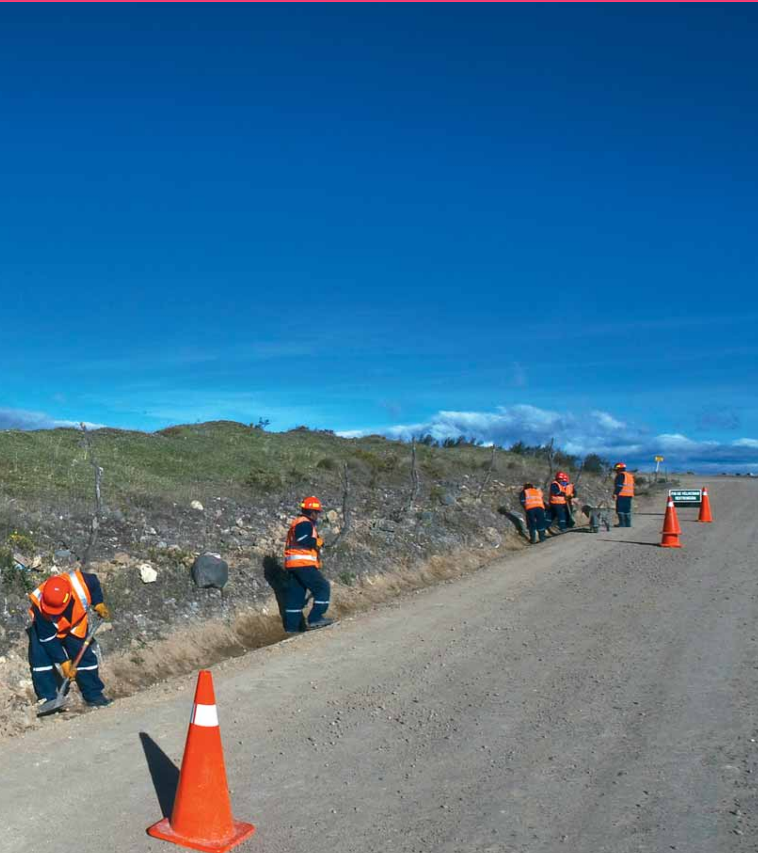
Vía El Empalme-Uchuquinua, La Zanja, Cajamarca
