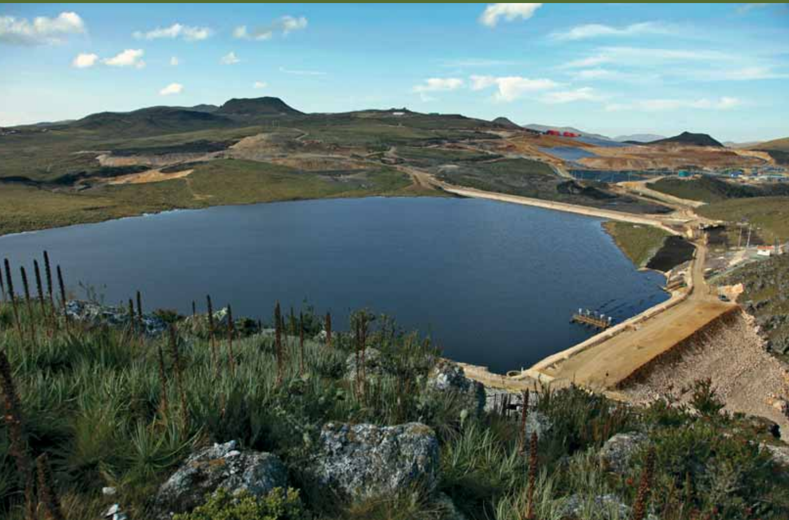
Presa Bramadero, La Zanja, Cajamarca
