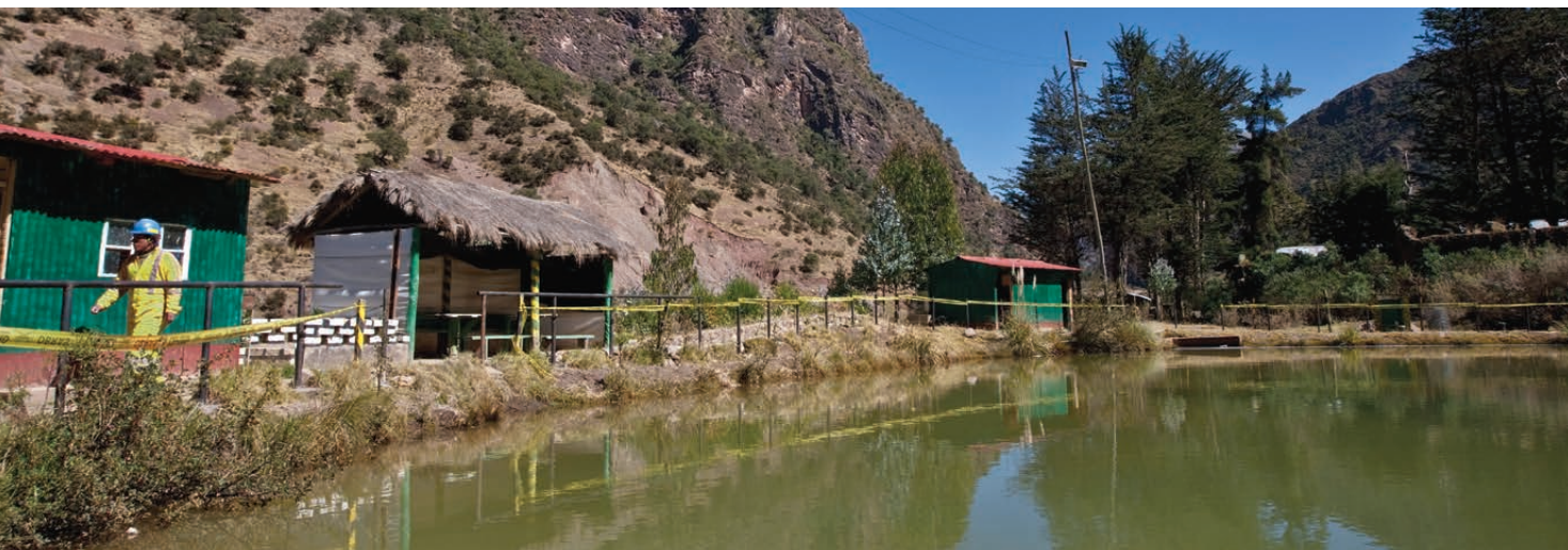
Planta de tratamiento de Palcas en Julcani.
