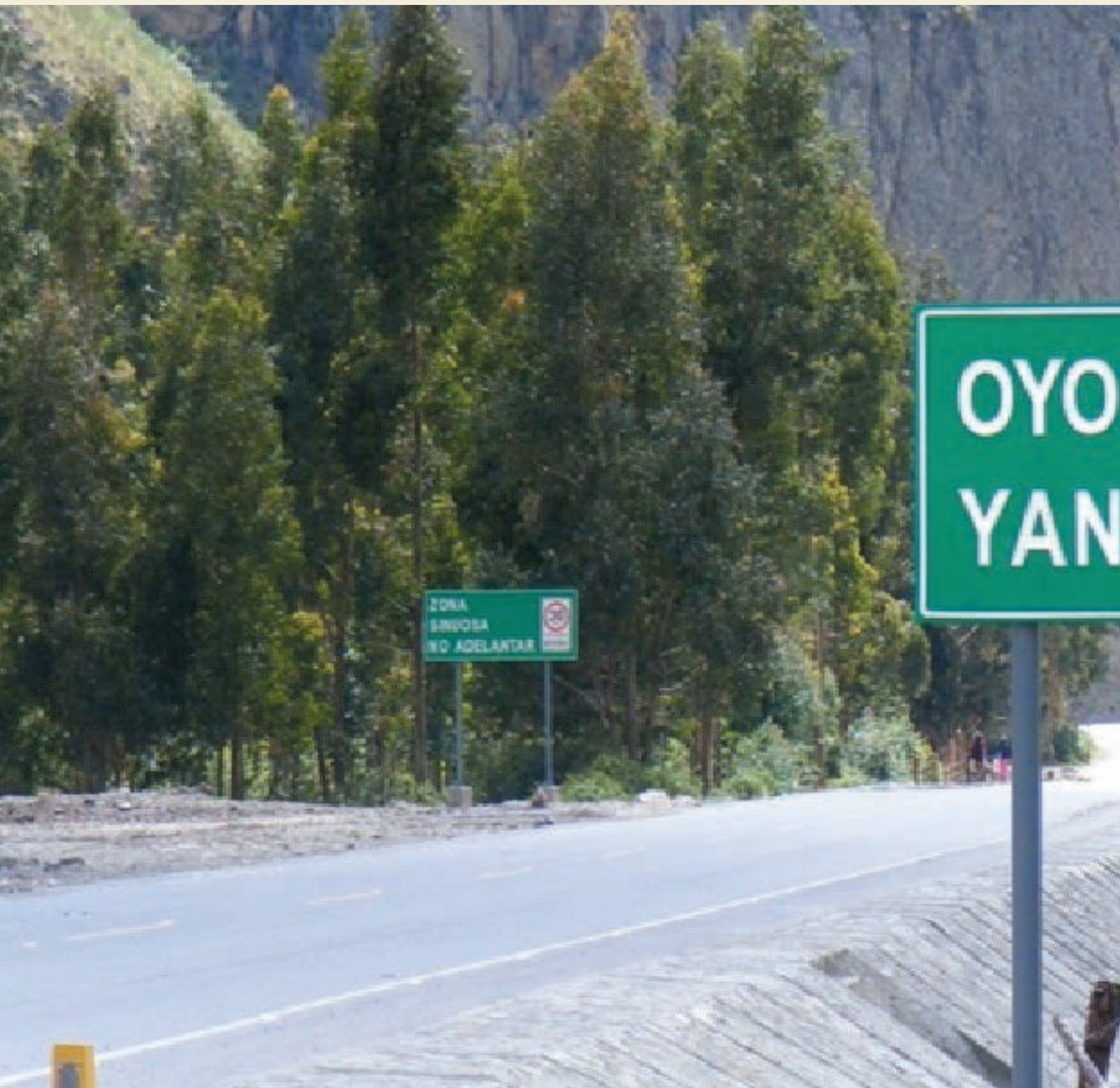
Buenaventura construye carreteras que facilitan la interconexión del territorio nacional. En la imagen, señalización de la carretera Churín-Oyón.
