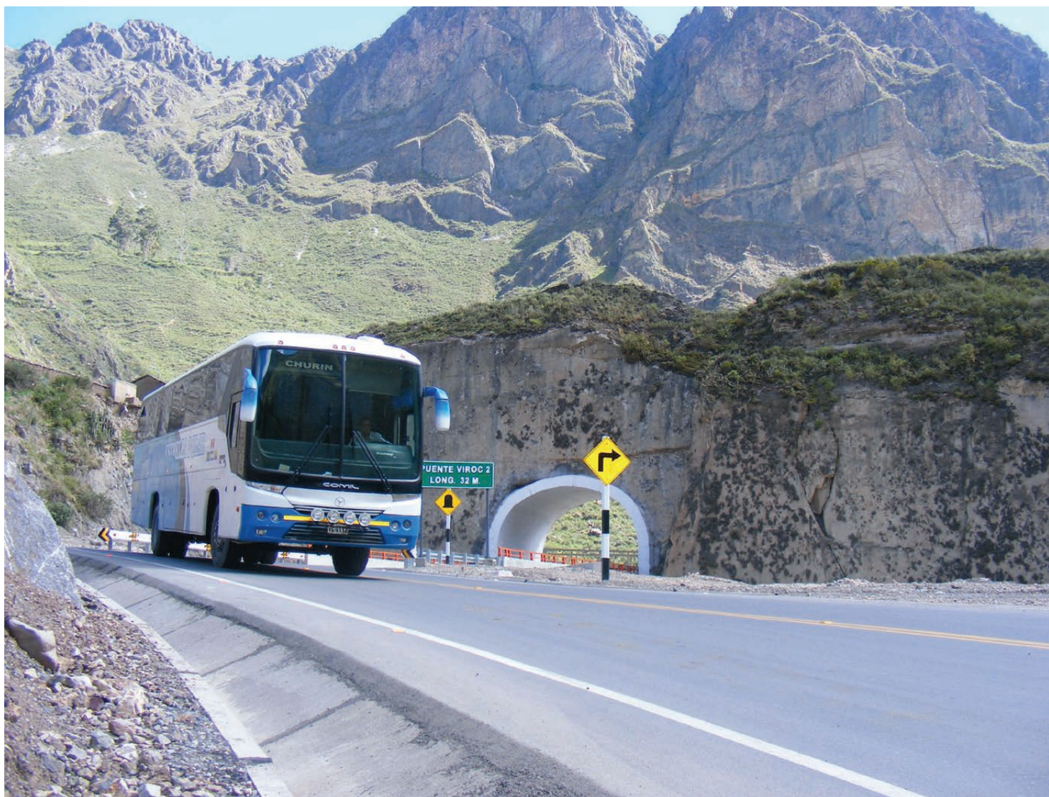
Buenaventura realiza minería responsable y propicia desarrollo descentralizado en las zonas más necesitadas del Perú. En la imagen, asfaltado de la carretera Churín-Oyón.
