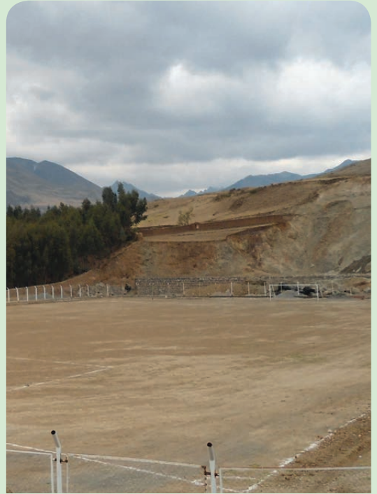
Obras de reconstrucción del estadio municipal de Oyón.
