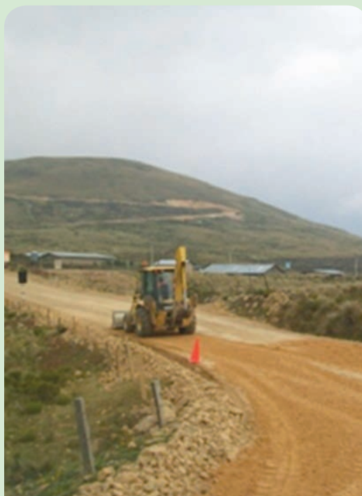
Construcción de vías.
