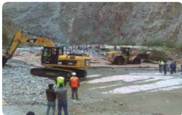
▲ Trabajos en carretera Huaura-Río Seco-Sayán-Churín-Oyón - región Lima
