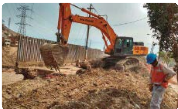
▲ Trabajos de reforzamiento en Av. Malecón Checa - Lima
