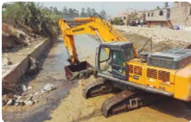
▲ Descolmatación del río Huaycoloro - Lima
