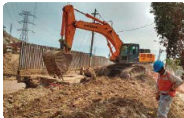
▲ Trabajos de reforzamiento en Av. Malecón Checa - Lima
