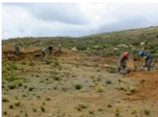
Fotografía N° 1: Configuración final de trinchera tipo lomo de pescado.
