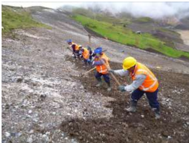
Fotografía N° 1: Personal obrero realizando la preparación del terreno en Sector Pozos Ricos.
