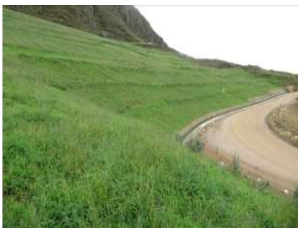
Fotografía N° 2: Vista panorámica del sector Lola – Atahualpa, una vez concluida el proceso de vegetación.
