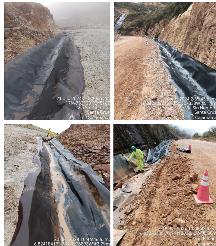
Limpieza y revestimiento de canales
