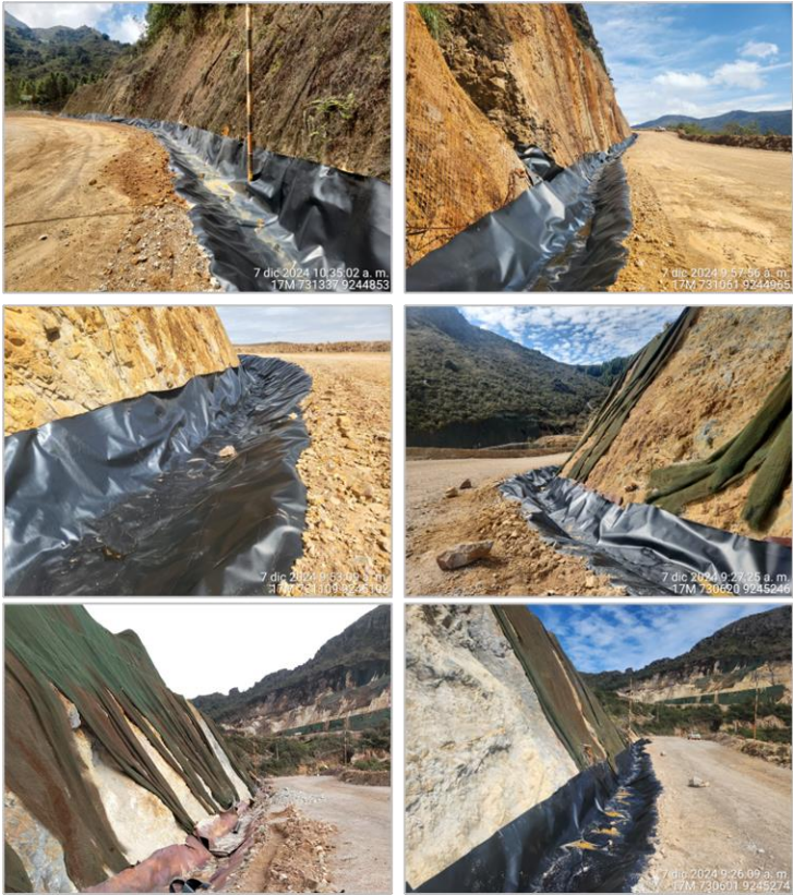
Limpieza y revestimiento de canales
